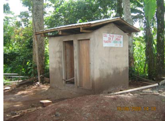
Un aspect des latrines offertes par AMEIBANS et Children's Fund aux deux écoles primaires citées
