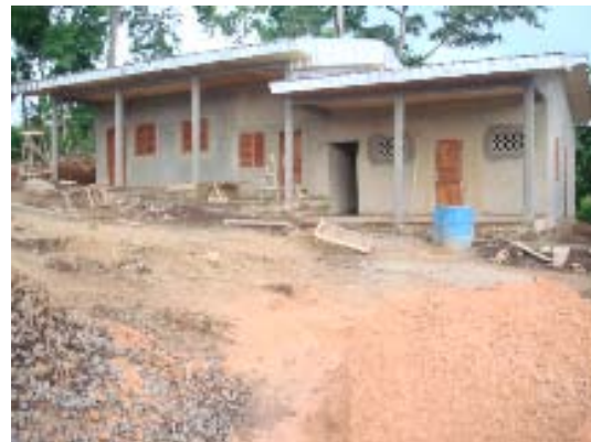
Une image du bloc administratif avec la cuisine, la bibliothèque, une salle d'ordinateurs et les toilettes modernes
