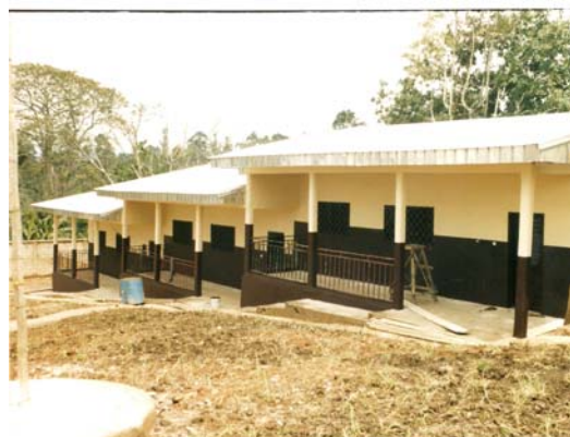
Une vue des bâtiments de la Kinder's House de Bandja en ce mois de juillet 2009
