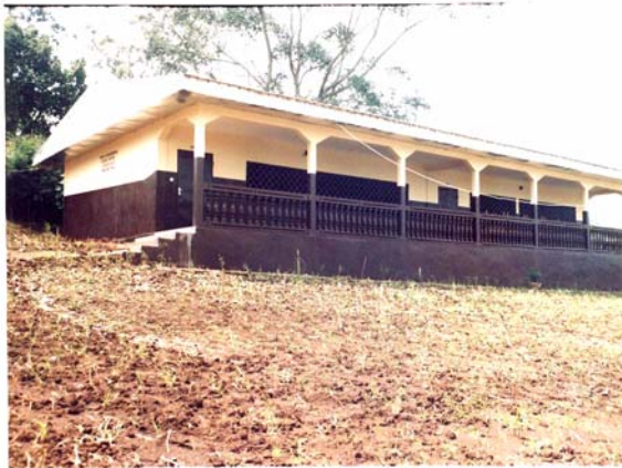
Les deux nouvelles salles de classe de la Kinder's House de Banock à la rentrée scolaire 2009-2010
