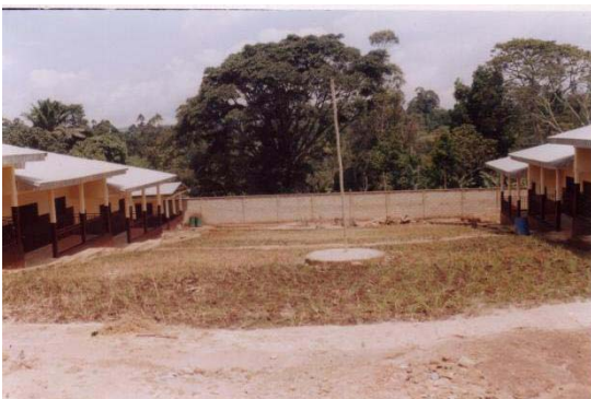
Une image de la nouvelle école Kinder's House de Bandja à cette rentrée scolaire 2009-2010
